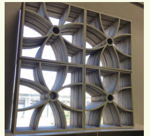
デザイン性と適度な昼光を取り入れる機能性を兼ね備えたシェーディングファサードの設計
