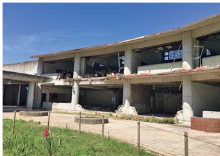
被災した小学校（校舎の外観）
