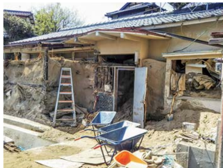
作業した家（外観）
