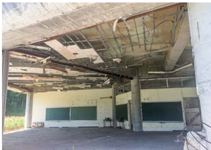
被災した小学校（教室の様子）
