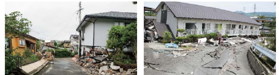
写真1 熊本地震による建物の被害（左：益城町の住宅被害、右：南阿蘇村のアパートの倒壊）
