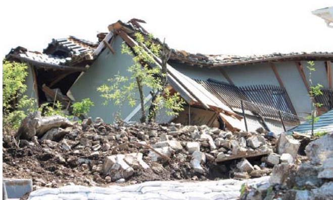
熊本地震で倒壊した家屋（2016年5月・熊本県益城町）
