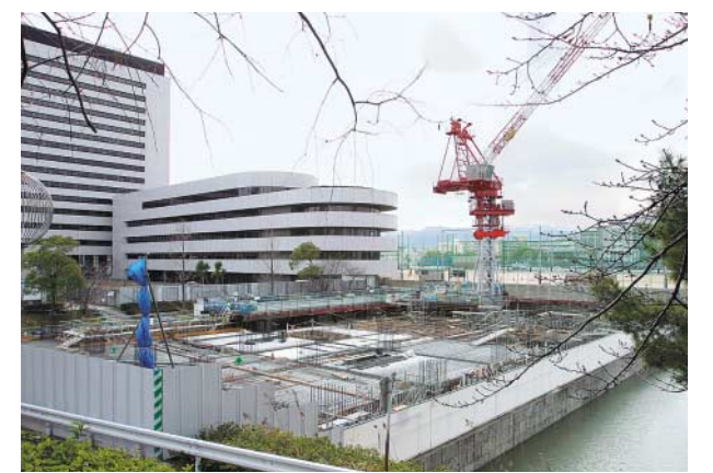
薬学部棟（仮称）建設進行状況（3月現在）
