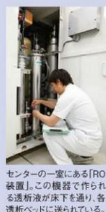
センターの一室にある「RO装置」。この機器で作られる透析液が床下を通り、各透析ベッドに送られている。
