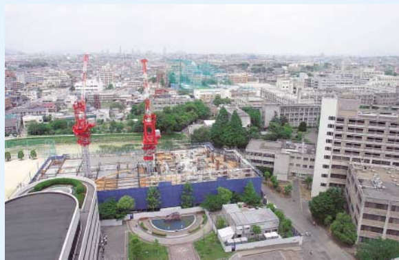
薬学部棟(仮称)建設進行状況(5月現在)
