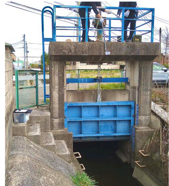
直方市 知古樋門でのセンサ設置風景
