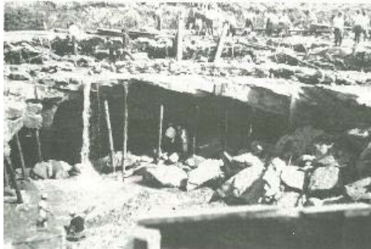
河床陥没の例 1
