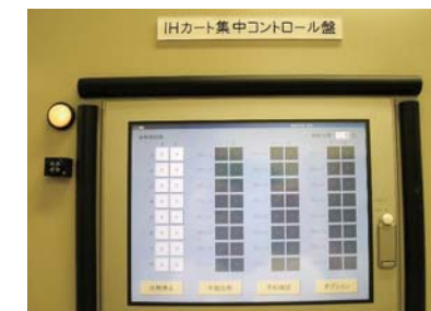
写真3 集中監視コントロールシステム
