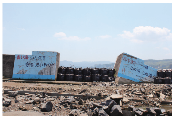
津波で壊れた防波堤
