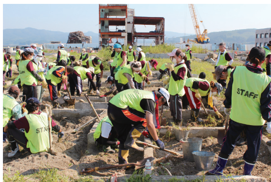
がれきの撤去作業
