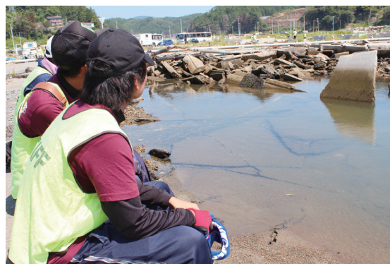
道路が陥没して海水が入ってきている
