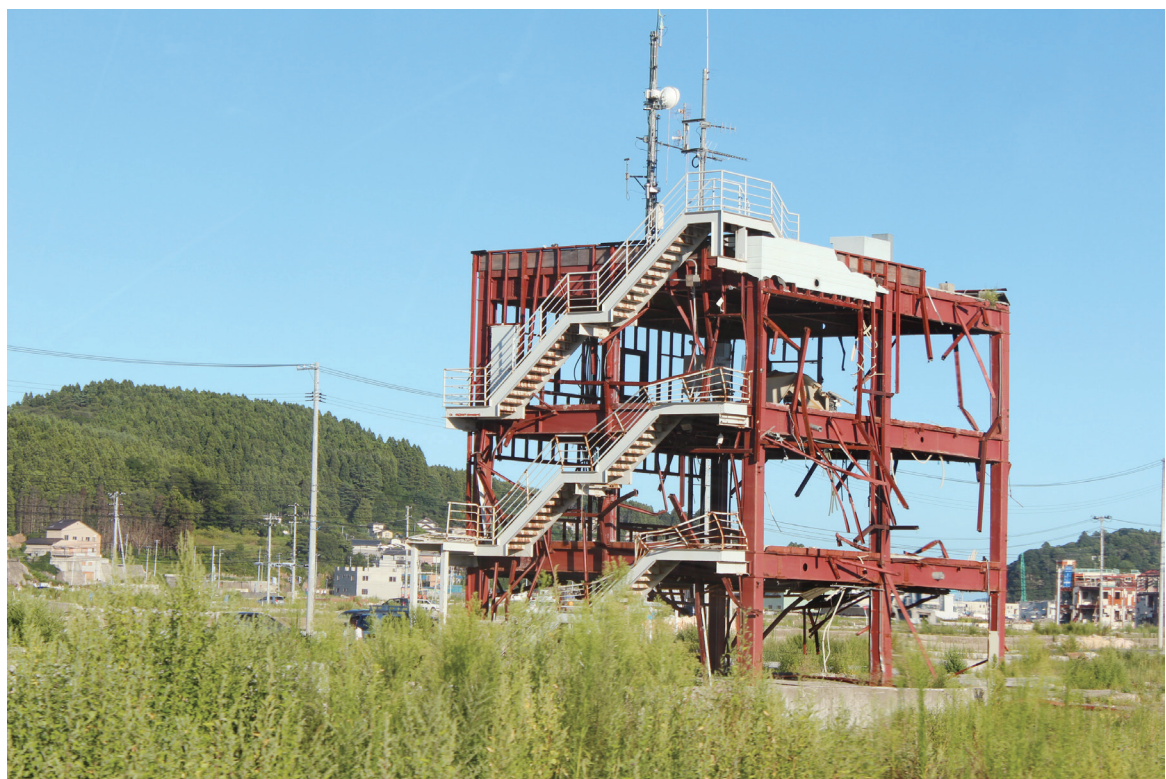
南三陸町役場の防災対策庁舎 骨組みだけが残った
