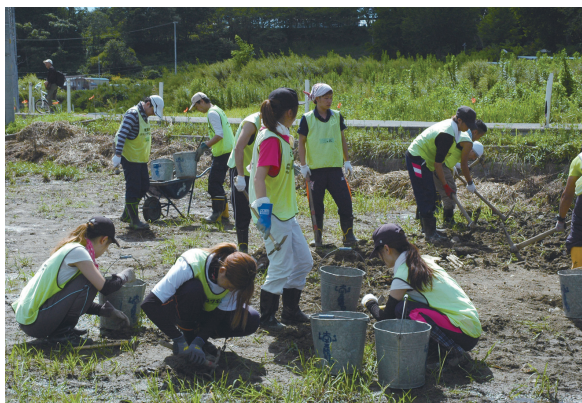
土砂に埋まったがれきの撤去作業
